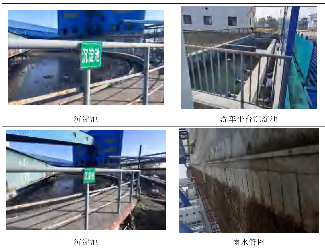
图 4-1 废水处理设施实际建设情况
